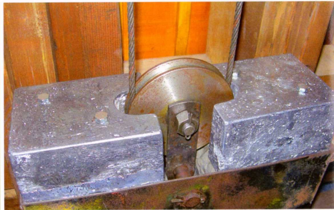
Realizzazione dei pani di piombo in aggiunta al contrappeso
