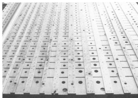
La parte superiore del pancone dopo la rimozione delle stecche: si notino le sedi di scorrimento e le false stecche
